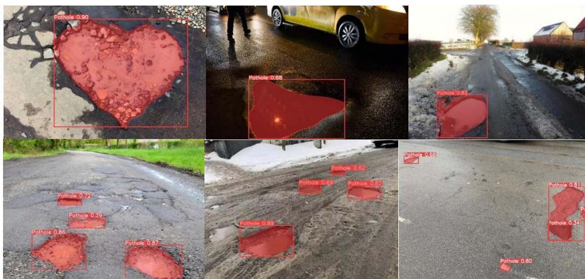
Рис. 3. Примеры верных результатов сегментации YOLOv8s-seg на тестовых изображениях UDTIRI
